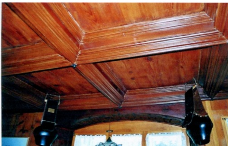
Lambris et plafond à caisson assez profond datant de (1600 ?) (Restauration en 1995 par J-P Hager locataire puis propriétaire)
